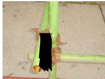
JUNTAS ORTOGONALES PARA ACOPLAMIENTOS EN ANDAMIOS TUBULARES.
